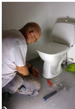
Arbetet har börjat!
